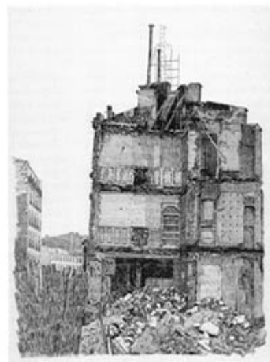
Démolition, Radierung, 1979, 298x395 mm
